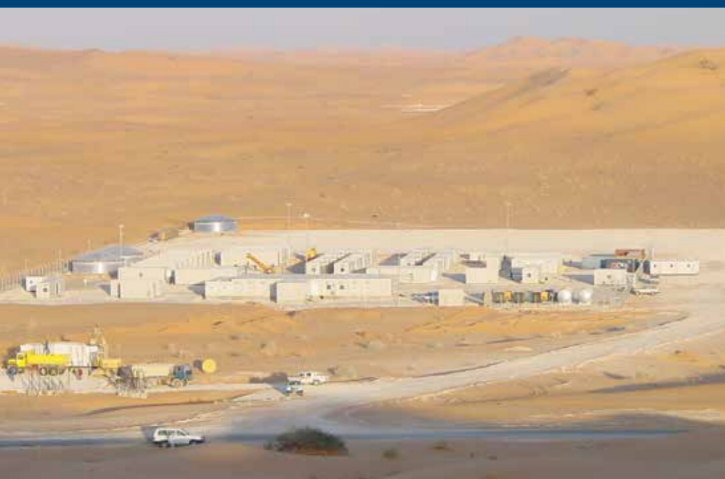
Struttura zincata a caldo
